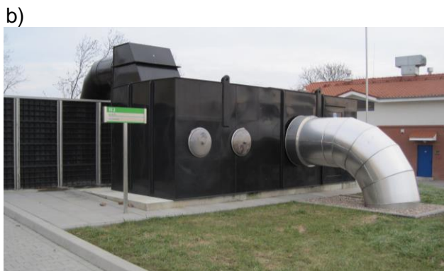
Rys. 3. Przykłady instalacji do dezodoryzacji gazów: a) adsorber węglowy. Źródło: https://www.monroeenvironmental.com ; b) biofiltr Źródło: http://www.aquanet.pl
